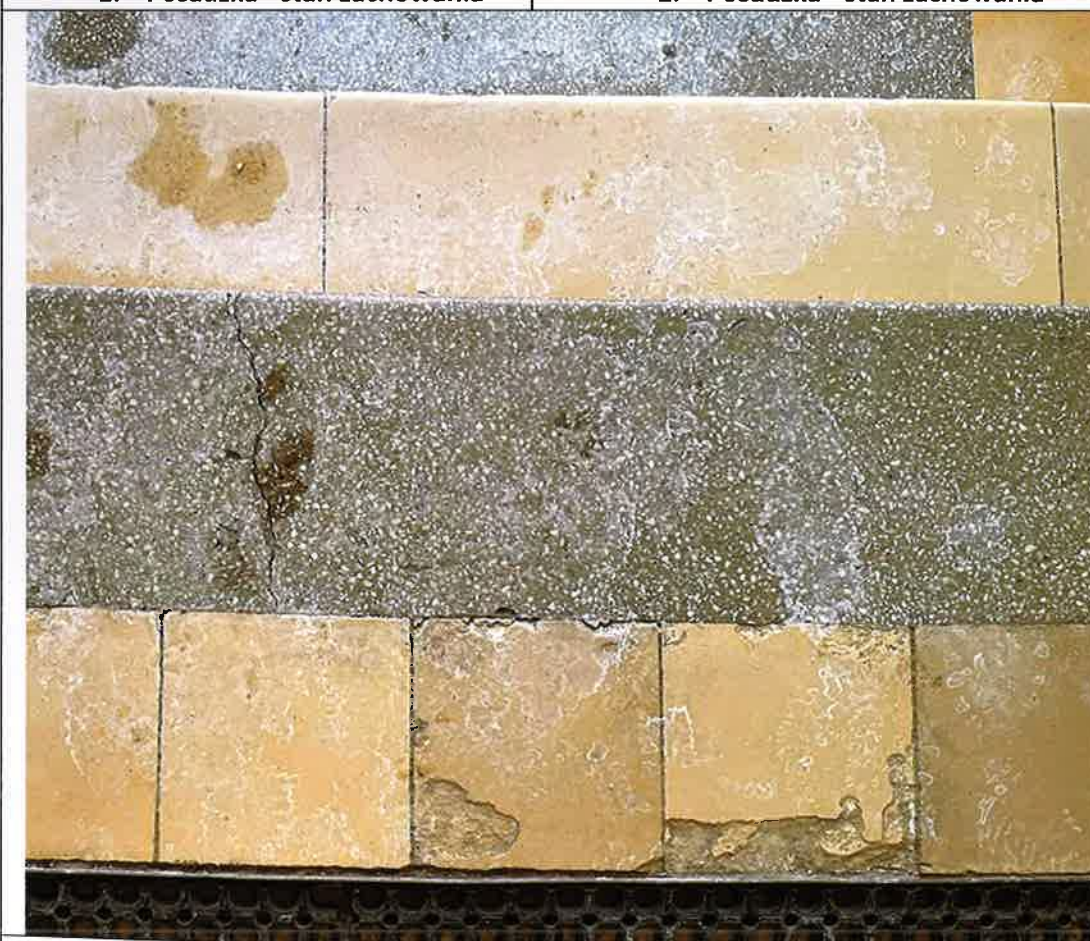
3. Posadzka - stan zachowania, zasolenie i ubytki materii oryginalnej
