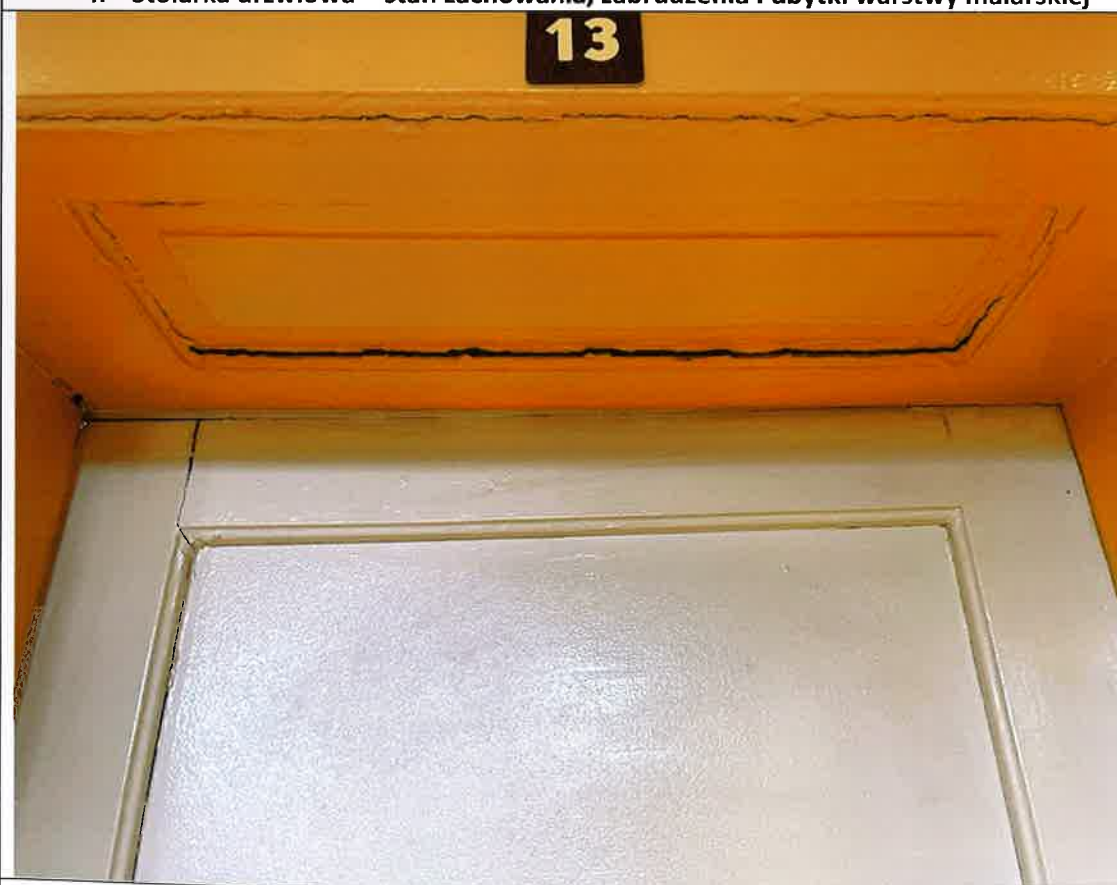
5. Stolarka drzwiowa – stan zachowania, widoczne spękania warstwy malarskiej
