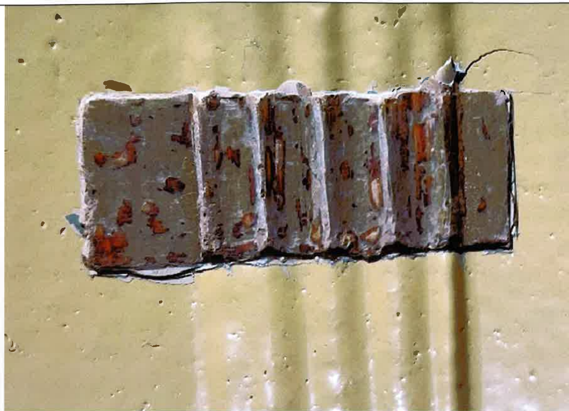
6. Stolarka drzwiowa – stan zachowania, wielokrotne przemalowania wpłynęły na brak czytelności detalu
