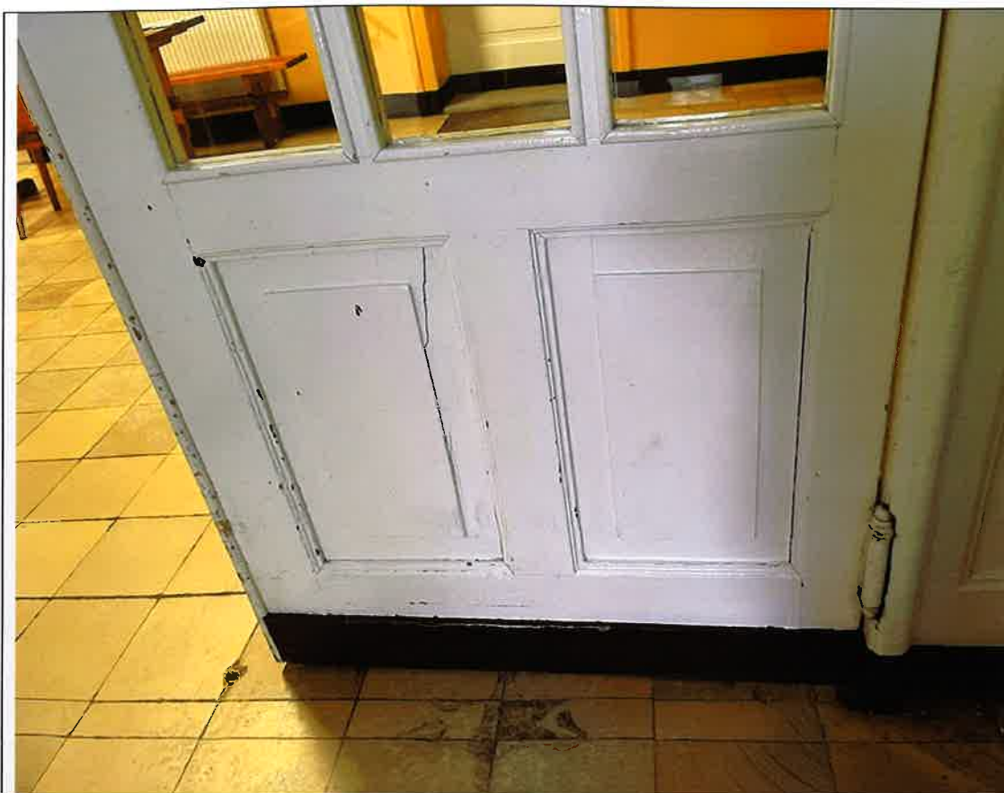
4. Stolarka drzwiowa – stan zachowania, zabrudzenia i ubytki warstwy malarskiej
